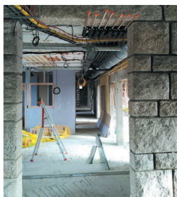
Vue depuis le hall d'entrée sur le couloir central desservant les bureaux
