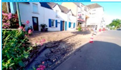
Places pendant les travaux
