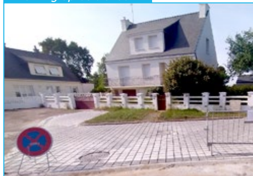
Parking après travaux
